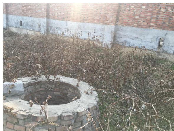
长垣站变电所（污水外排口）
