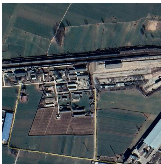
延津站牵引变电所
