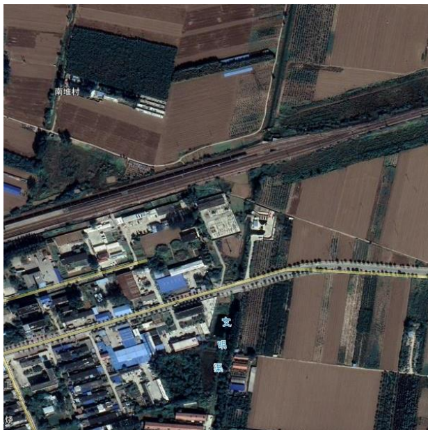
长垣站牵引变电所
