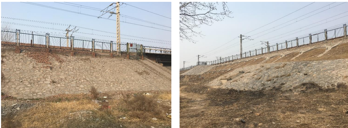
沿线路基边坡情况
