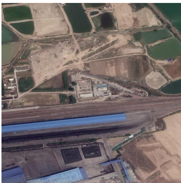
新乡东站牵引变电所
